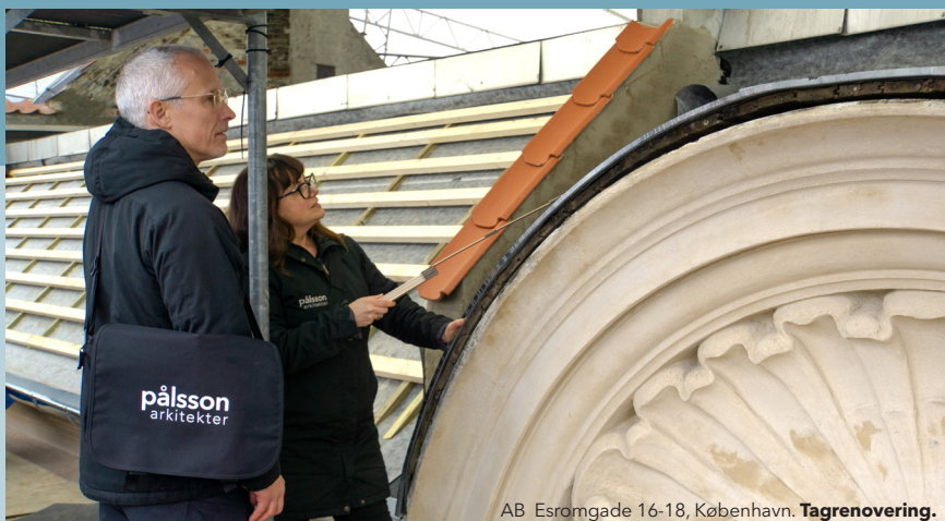
AB Esromgade 16-18, København. Tagrenovering.
